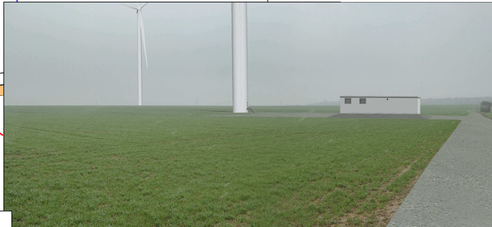
Après l'implantation de l'éolienne
