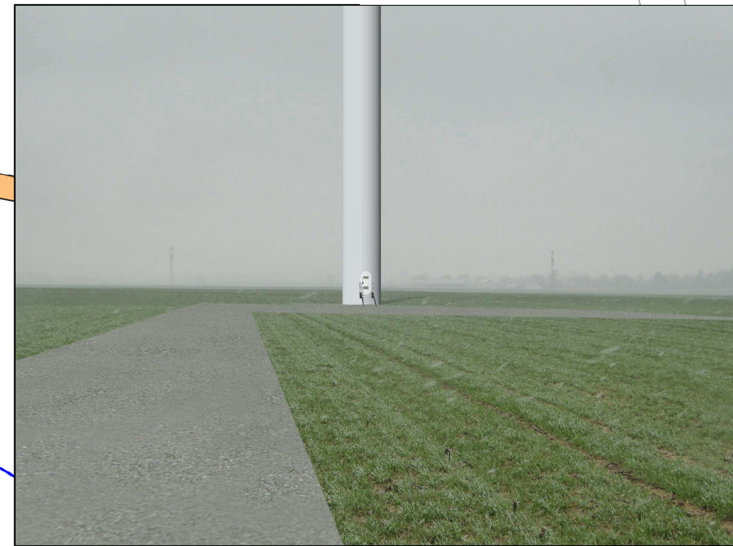
Après l'implantation de l'éolienne
